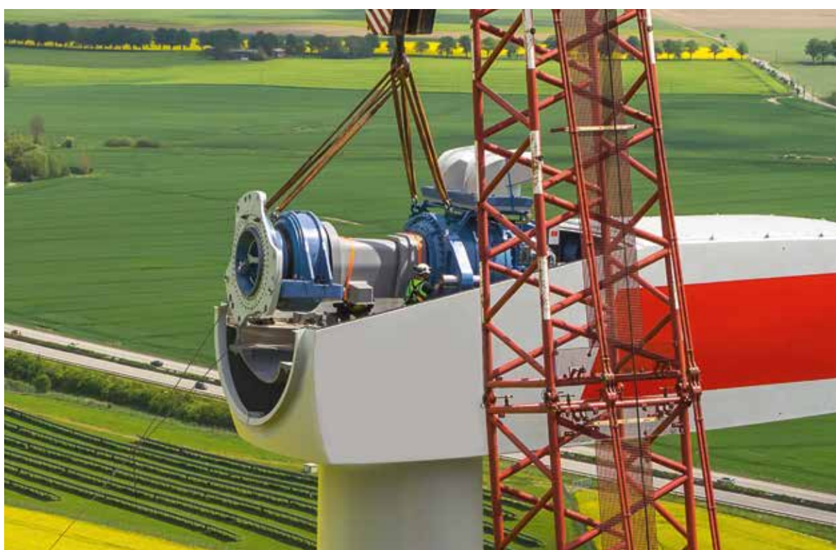
Montage in luftiger Höhe: Ein Anwendungsgebiet für Gleitlager sind die Hauptgetriebe von Windkraftanlagen.
